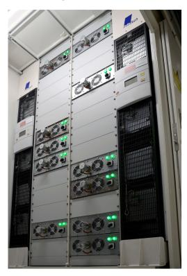
Teile der IT-Fläche des MDC40 mit Lastwiderständen. Durch 20 Lastwiderstände je 3KW wird die volle IT-Leistungsaufnahme simuliert.
